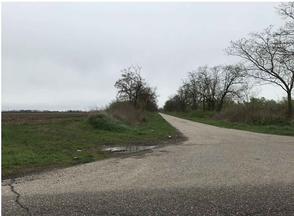
Útcsatlakozás a 4113 - Mándok-Lónya-Tarpa összekötő út, szelvényszám: 29 km 830 m
