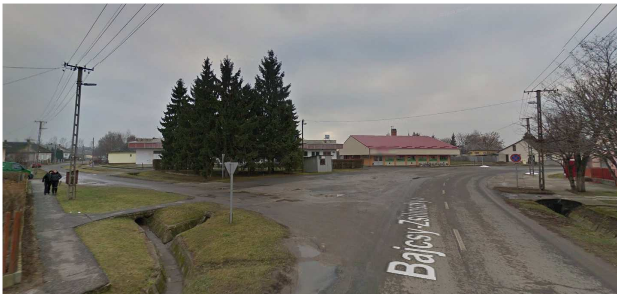
Útcsatlakozás a 4113 - Mándok-Lónya-Tarpa összekötő út – Arany J. u.
